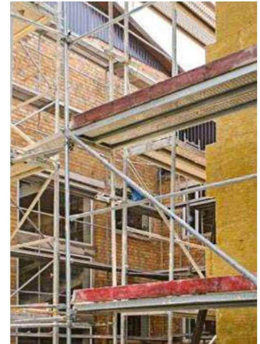
Engures vidusskolas ēka fasādes siltināšanas darbu laikā
