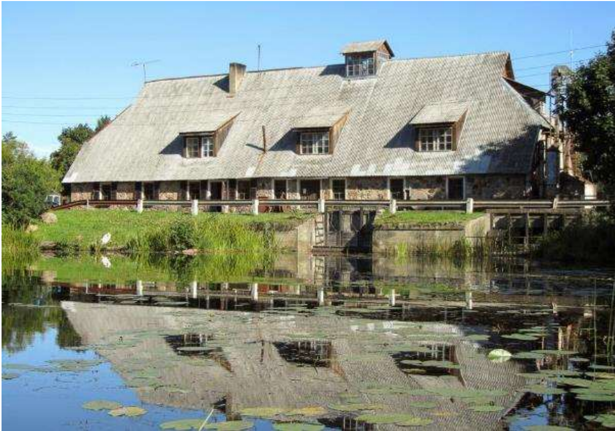
Rideļu dzirnavu ēka, kurā šobrīd iekārtots viesu nams ar pirti un kafejnīcu, un Rideļu dzirnavezers
