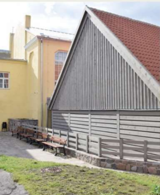
Atjaunota peldbaseina ēka 3,1 milj. €
