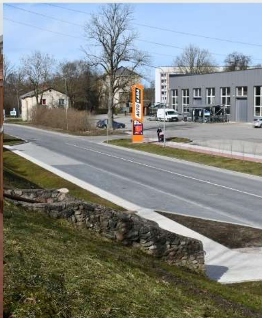
Virkas, Tehnikās, Īsās, Akmeņu, Lapegļu ielas posma pārbūve Kuldīgā
