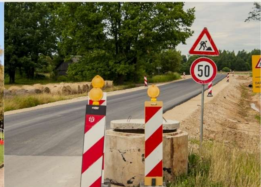
Caurtekas un saistītā ceļa seguma atjaunošana pār Riežupi, Rumbas pagastā 457 tūkst. €
