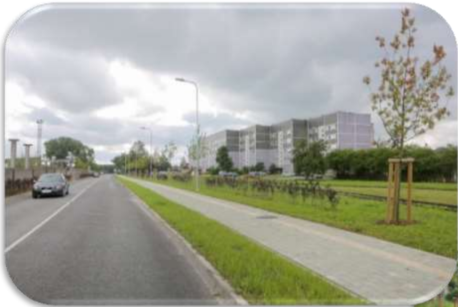
Neretas iela - 540 m (pārbūve)
