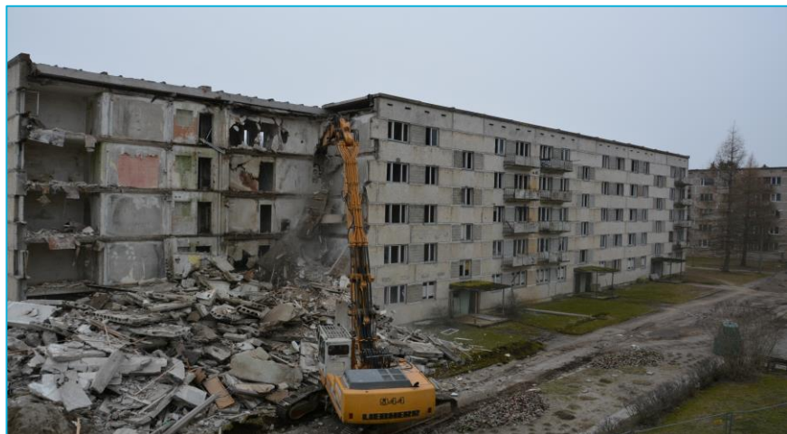
DEGRADĒTAS ĒKAS NOJAUKŠANA VENTSPILS NOVADA UGĀLĒ /VENTSPILS NOVADA FOTO/
