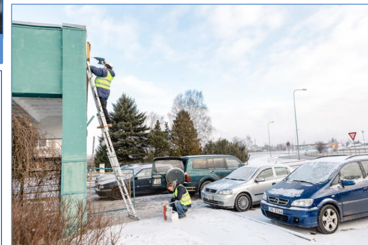
VIDEONOVĒRŠANAS KAMERU INSTALĒŠANA SALDŪ /SALDUS NOVADA PAŠVALDĪBAS FOTO/
