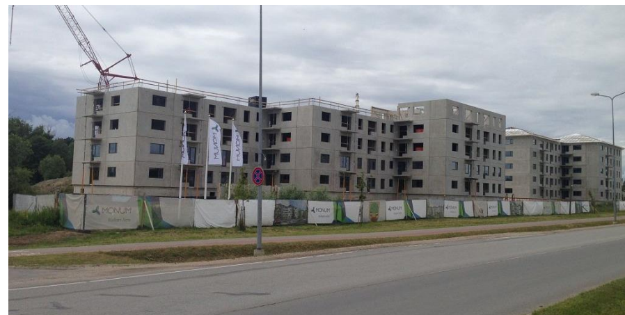
Īres namu būvniecība Valmierā - dzelzsbetona konstrukcijās
