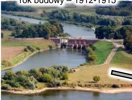
Biała Góra rok budowy - 1912-1915
