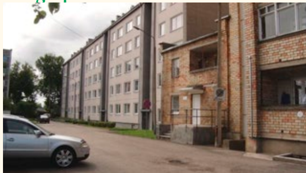
Latgales reģiona ģimeņu atbalsta centrs Daugavpilī
